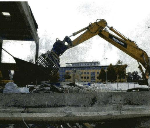
gesetzten Anbaugeräte waren mit dem vollautomatischen OilQuick-Schnellwechselsystem ausgerüstet die einen wesentlich positiven Einfluss auf die Produktivität, die Flexibilität und auch der Sicherheit hatten.
